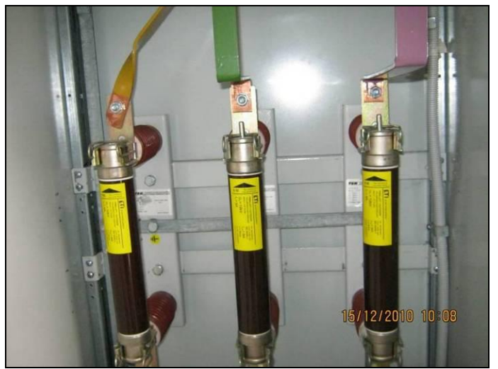
Slika 10. Pregorevanje osigurača u mernoj ćeliji
