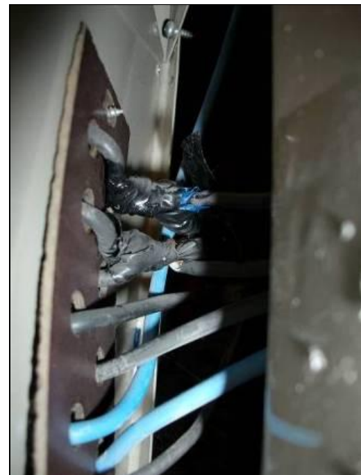
Slika 6. Kratkospajanje iza brojila
