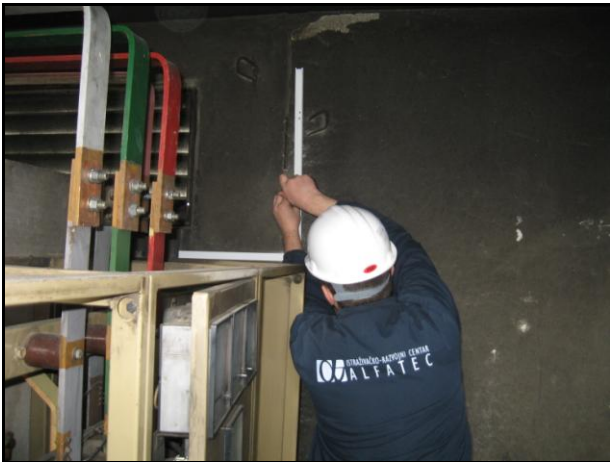
Slika 1. Postavljanje kanalnica za kablove
