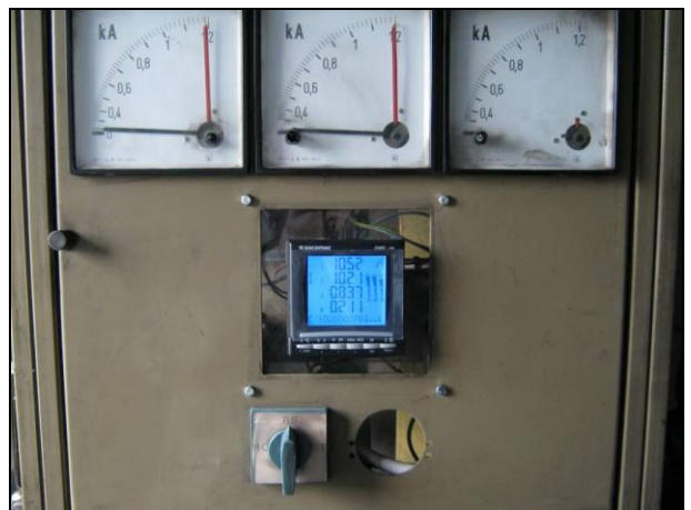
Slika 4. Merenje električnih parametara u TS
