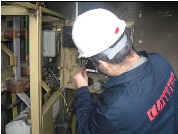
Slika 3. Povezivanje panelnog mrežnog analizatora
